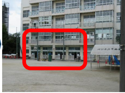
□囲み部分が、昇降口
